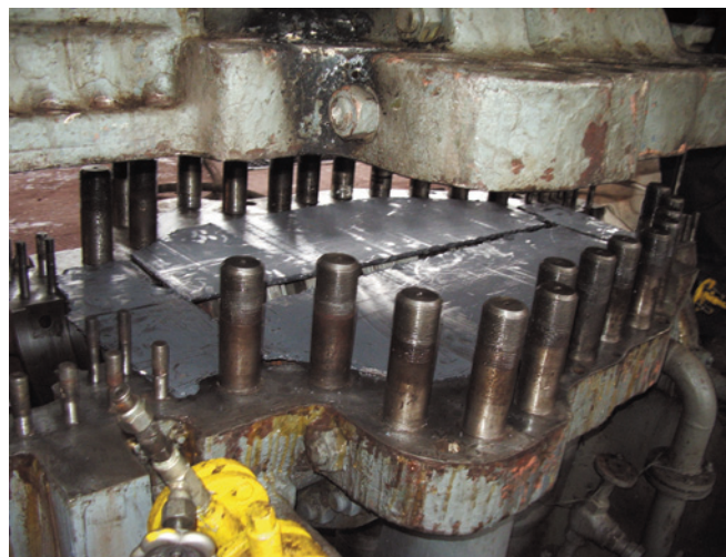
Рис. 3. Низкоплотные маты ТРГ, уложенные на разъем
